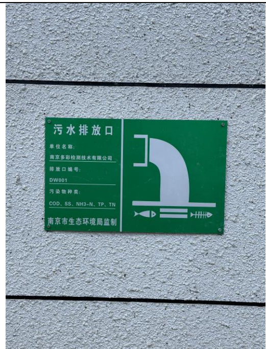
污水排口标识牌
